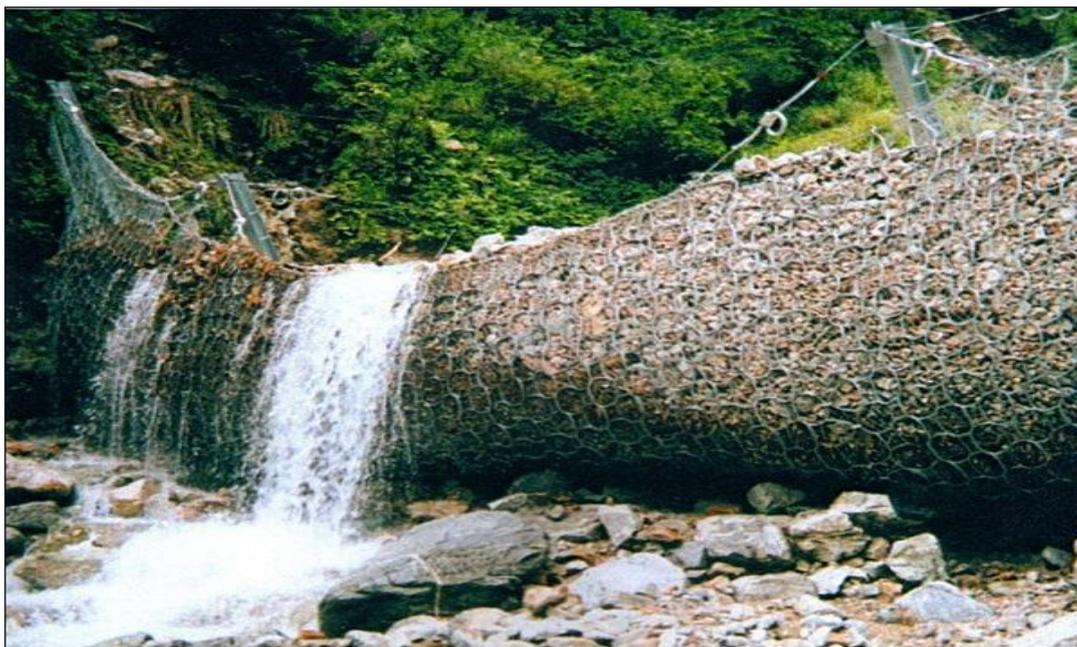
**Рисунок 4.36 – Облегченное гидротехническое противоселевое сооружение**
